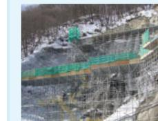
安全性と効率性が高く、作業員の熟練度に関係なく、常に同じ高品質の作業構台を構築できるシステム構台です。部材のユニット化によって、組立・解体、盛り替えや転用施工も容易で経済的です。棧橋用の部材も準備されているので、橋梁現場のほか、都市型土木でのシステム足場・システム支保工などとしても活躍しています。
