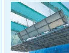
経年化した高速道路などの床板取替工事に活用され、維持修繕工事でも使用するパネル式吊り棚足場です。開閉式の床を採用しており、すき間・段差のないフラットな作業床を実現するなど、細部にわたって安全性と施工性を追求しています。吊り棚足場工法において、仮設パネル上ですべての作業が行える進化形パネル式吊り棚足場です。
