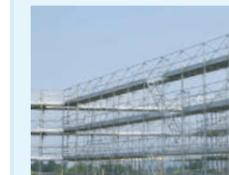
軽量パイプを使用し、抜け止め機能を有した、従来のクサビ式足場を上回る作業性と安全性・同水準の経済性を実現しました。階高190cmを採用することで、足場上で腰をかめることなく作業や通行ができることから作業者への負担を軽減します。次世代を担う、一歩先に進んだ安全性を提供する次世代の足場システムです。
