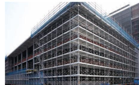
現在の実態に合わせた足場規格の変更や、労働災害防止策の強化など、足場業界の革新と新規格での次世代足場の開発を進めました。従来の足場の安全性や作業性の課題が顕在化してきた中、50年にわたり、変化のなかった仮設足場を変革するために、2010年に仮設機材メーカーのホリー株式会社を連結子会社化することでメーカー機能を獲得しました。2013年に次世代足場「Iqシステム」を開発し、市場へ投入しました。Iqシステムは従来の足場の階高170cmより、階高が20cm高い、190cmで、安全性と施工性が大幅に向上しており、作業者の身体的な負担を軽減することができます。現在では業界のデファクトスタンダードの地位を固めつつあります。また、金属加工技術を活かした制振フレームや農業用ハウスの開発、太陽光発電パネルの設置架台など、新領域へ業務展開しました。
